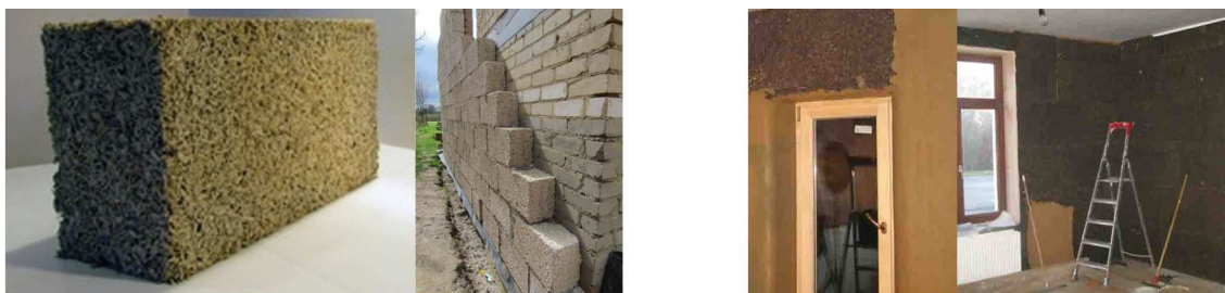
Blokken in hennep-kalk voor de isolatie langs buiten
