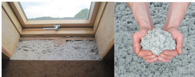
Isolatie dak met ingeblazen cellulosewatten
