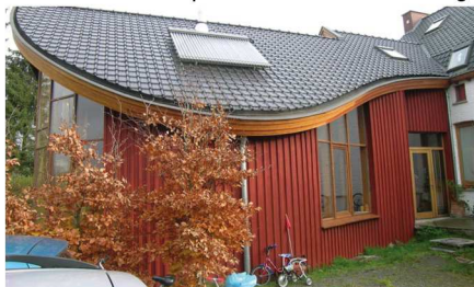
Gevelbekleding met ruwe Belgische lork + Noorse oude verftechnieken
