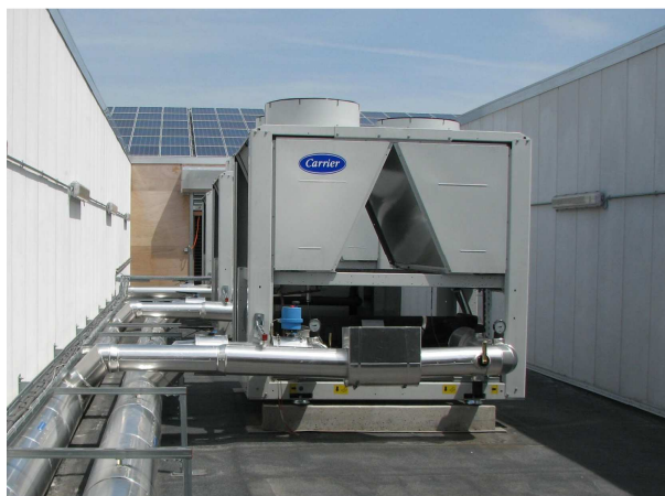
Luchtgekoelde chiller Afbelding van de installatie en het werkingsprincipe
